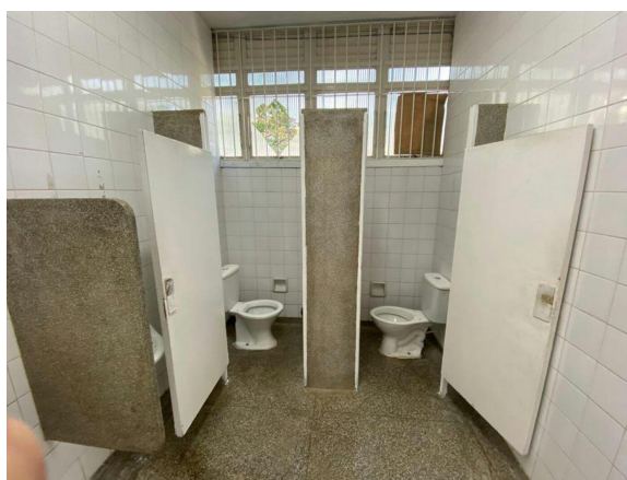
banheiro não acessível (2)
