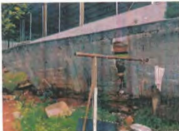
Figura 6: Pilar totalmente "separado" da viga
