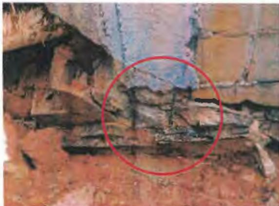
Figura 8: Armadura aparentemente não condiz com a funcionalidade do elemento estrutural
