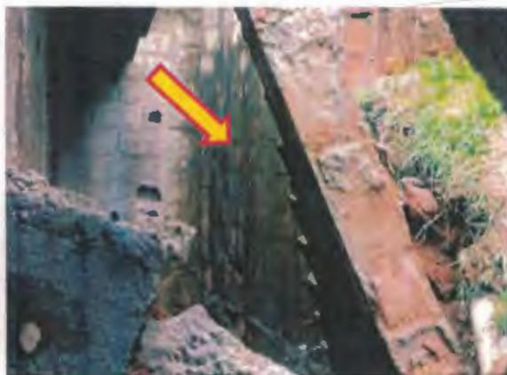
Figura 9: Umidade da face externa do muro evidencia ausência de sistema de drenagem
