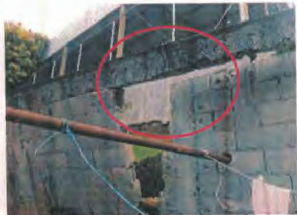
Figura 7: Detalhe da figura 1: falta de solidarização entre elementos estruturais
