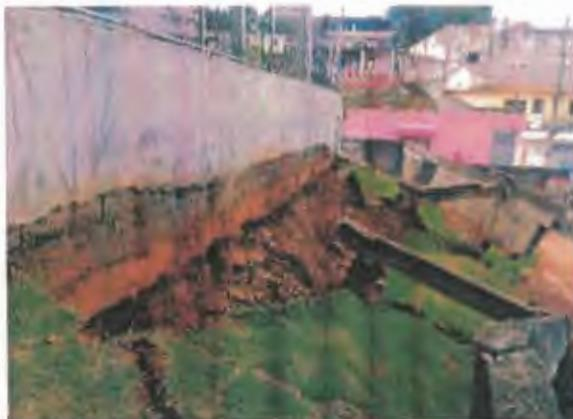
Figura 10: Descalçamento do piso da quadra
