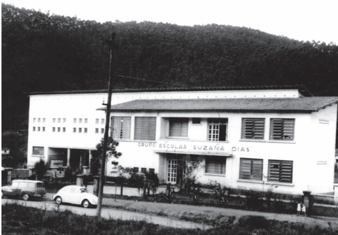
Prédio do Grupo Escolar Suzana Dias no início da década de 70, construído na década de 50.
