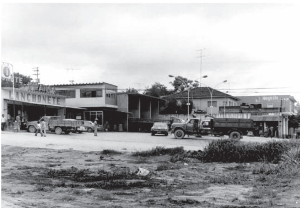
Início da construção do posto Ipiranga na Avenida Jordano Mendes no distrito de Jordanésia, década de 70.
